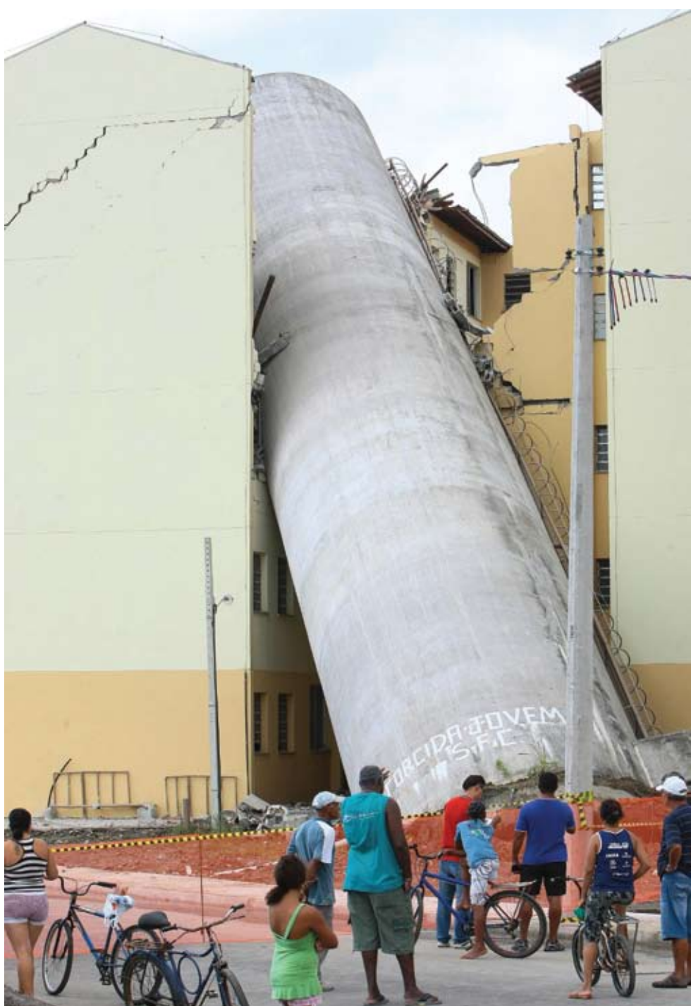
Caixa d'água que caiu sobre os prédios na Vila Pelé
